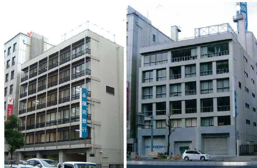
1.1 補強前 1.2 補強後 写真1 耐震補強前後の外観
