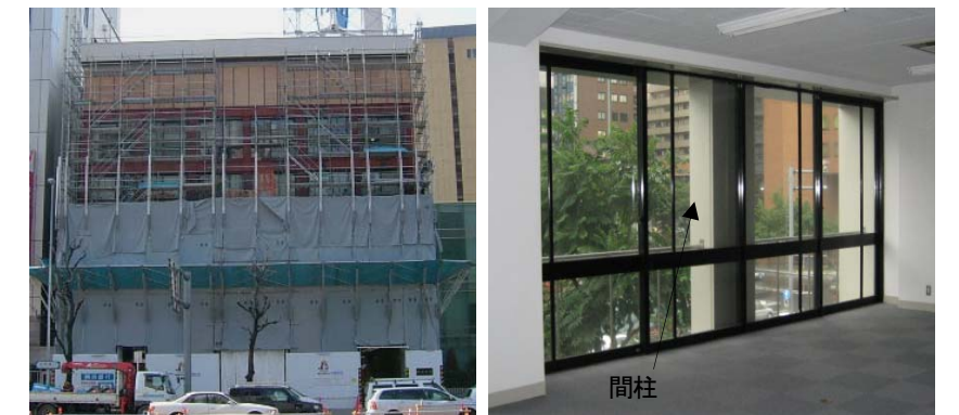
2.3 鉄骨フレーム設置 2.4 補強後内観
