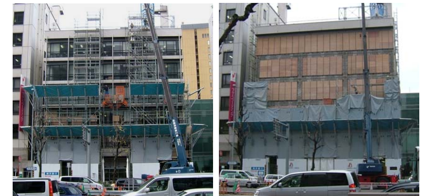
2.1 既存仕上げの撤去 2.2 あと施工アンカー打設
